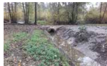
Curage après entretien de la végétation de la boire de l'Abbaye et remplacement d'un busage (Cormery - 2016)
