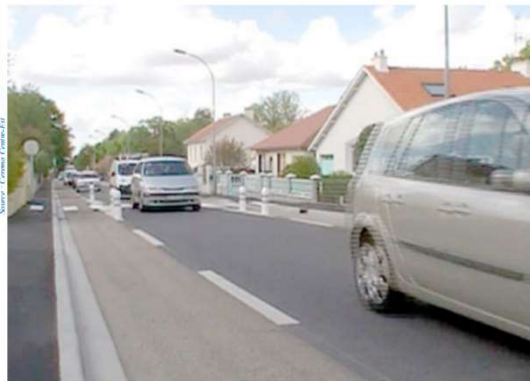
Traitement de la rive par enrobés grenaillés
